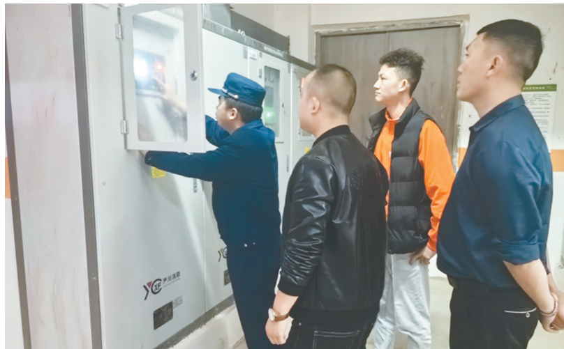
检查消防设施
