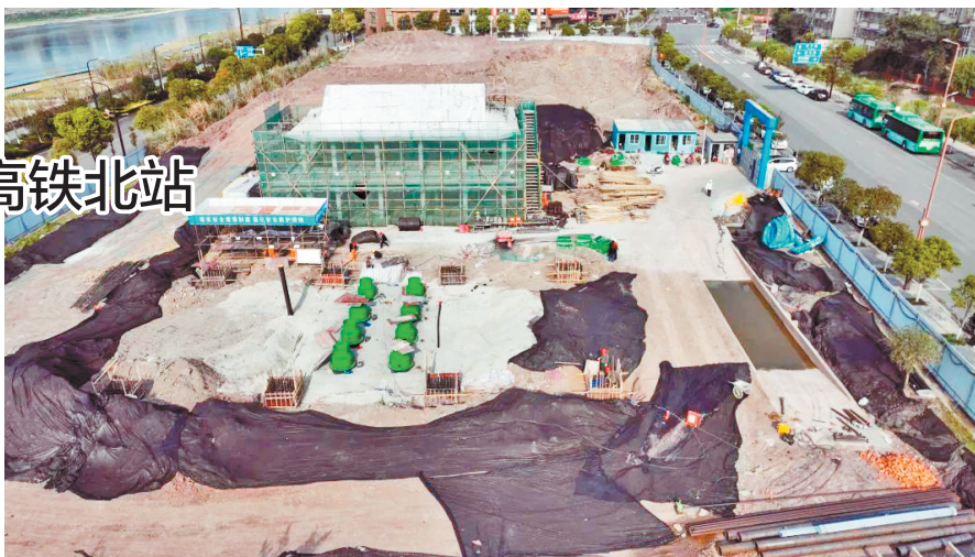
资中县罗汉洞加油站施工现场
