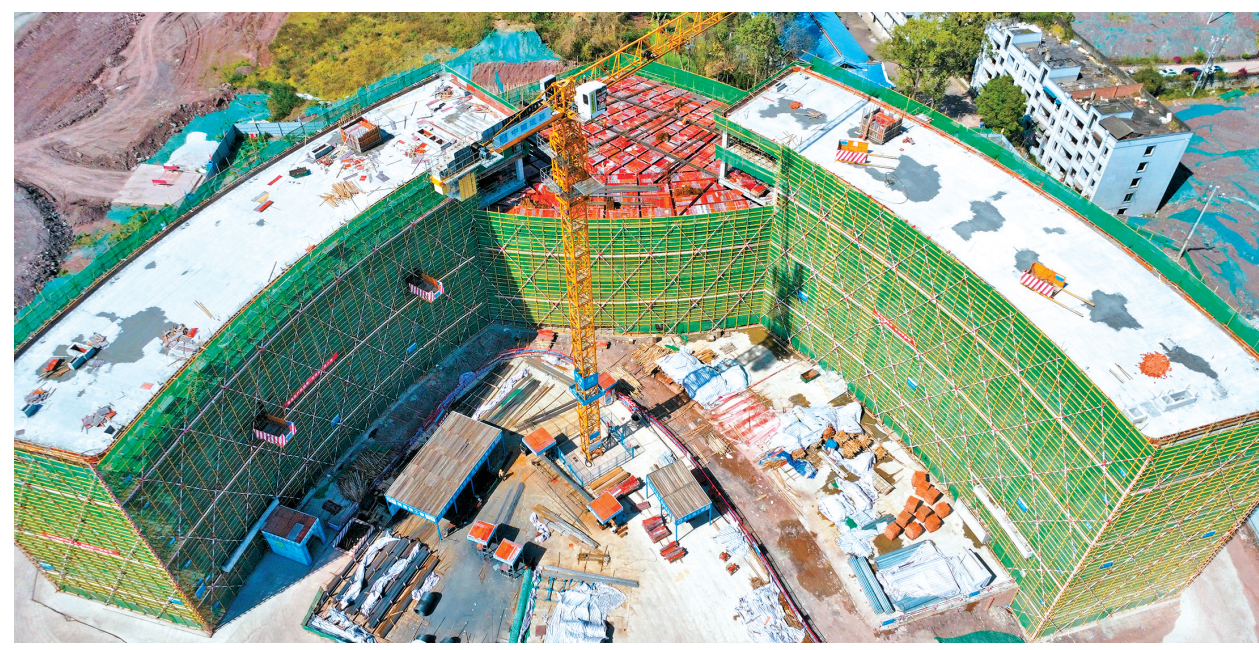
已封顶的成渝地区双城经济圈农业科技创新孵化平台
