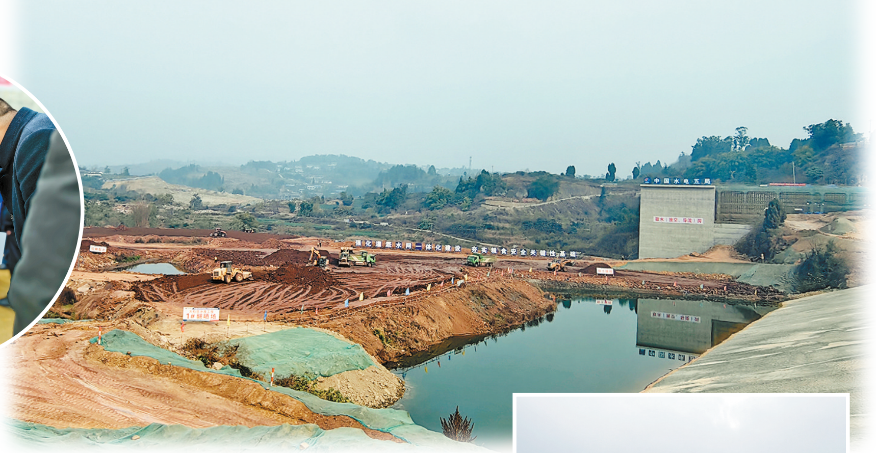
威远县大石包水库建设现场
