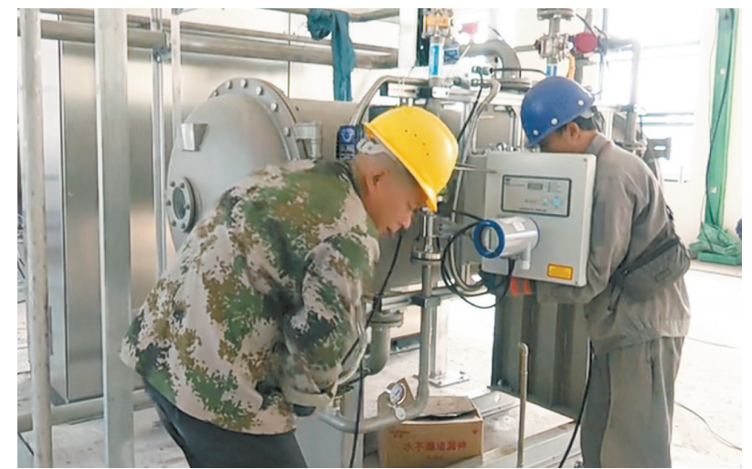
技术人员调试设备
