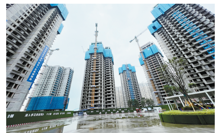
项目施工现场
