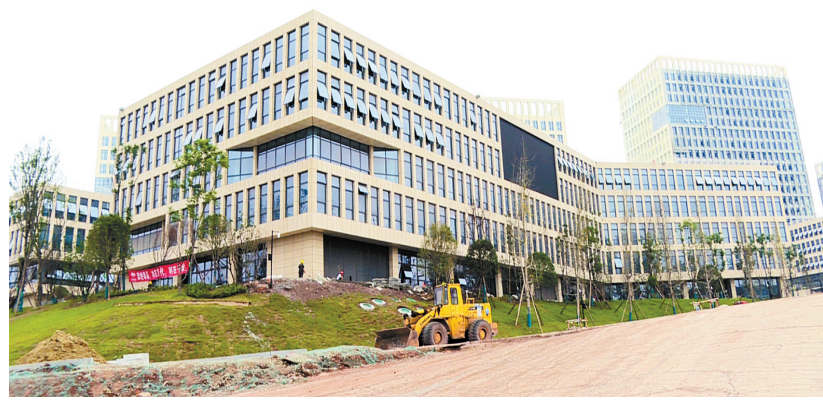
项目建设现场
