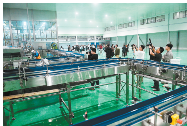
参观红牛饮料(四川)生产基地正在建设的生产线
