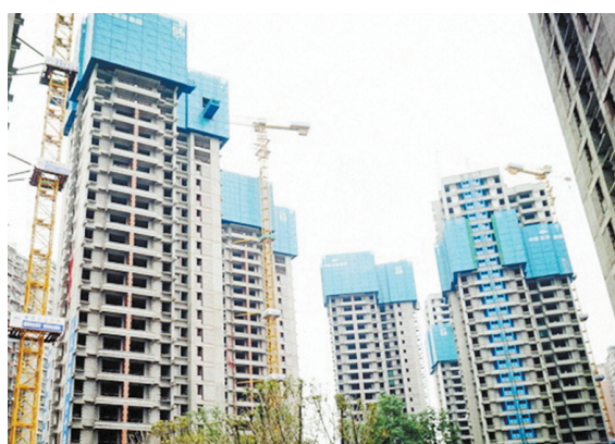
市中区蟠龙坝片区棚户区(城中村)改造项目主体已全部封顶
