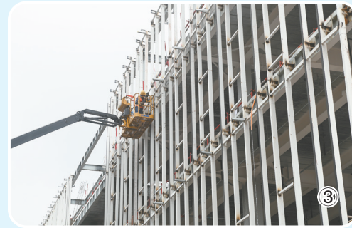
①内江高新区智能制造精密器件产业园项目建设现场 ②安装钢构件 ③高空电焊作业 ④捆扎钢筋
