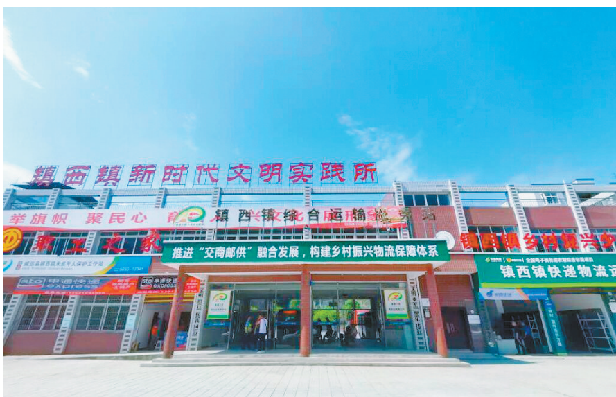
威远镇西镇客运站改造为集客运、货运、快递、电商等多种功能于一体的综合运输服务站
