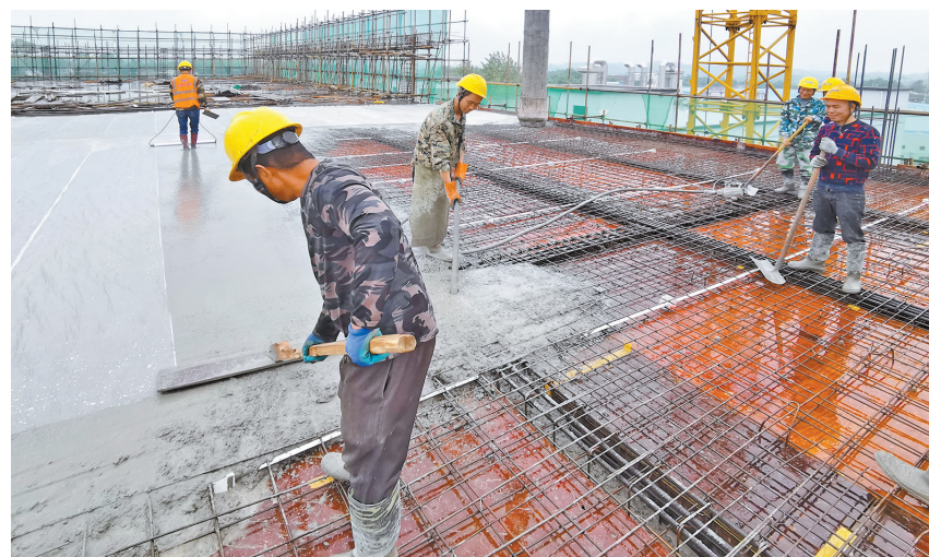
工人正在进行水泥浇筑
