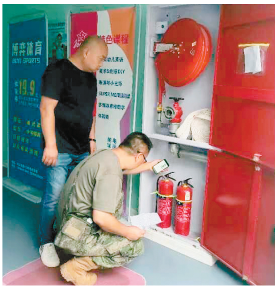
检查消防设施
