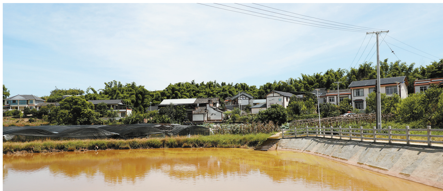
新建水利设施
